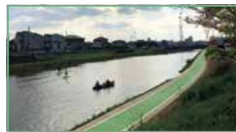
新しく設置した古利根川沿いの遊歩道
