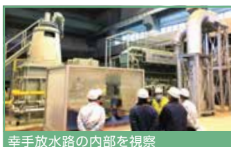
幸手放水路の内部を視察
