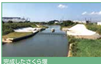
完成したさくら堰
