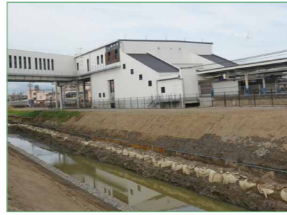
幸手駅沿いを流れる倉松川の河道を拡幅する工事。
