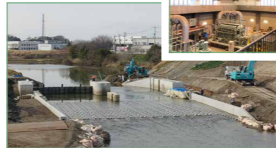
完成が見えてきた工事現場。大きな堰をつくり、水量調整を可能にします。
