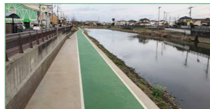
新しく県が設置した古利根川沿いの遊歩道。
